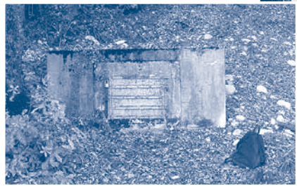
Page de gauche: Chambre de captage défectueuse.
