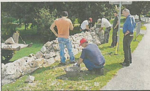
La construction d'un mur en pierres sèches avec, à droite, l'organisateur de la journée Guy Reymond, du bureau ProConseil d'Yverdon-les-Bains.
