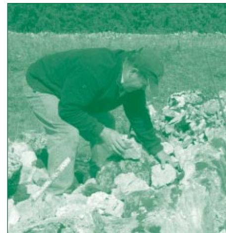
La (re)construction d'un mur en pierres sèches est présenté par le muretier Antonio Farinho.
